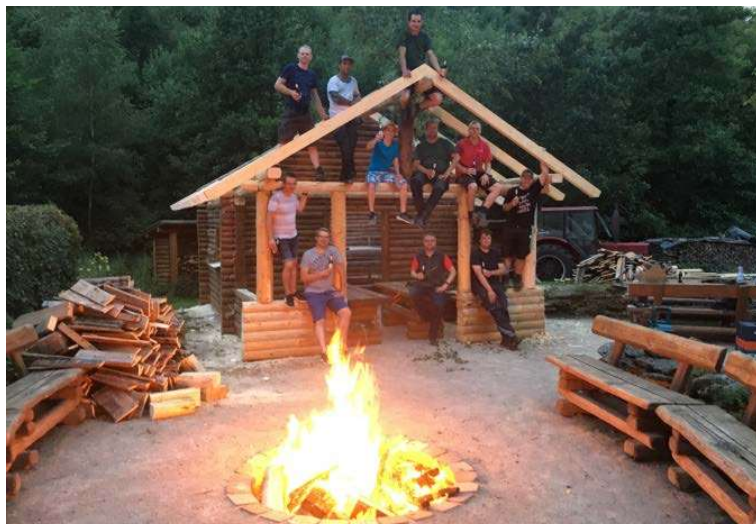
2019 stand die Renovierung der Grillhütte an. Hierbei wurde unter anderem das Dach erneuert.
